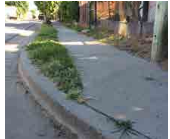
VEREDA Y CORDÓN CUNETA
