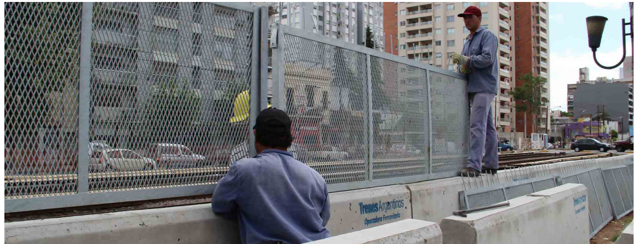
ILUMINACIÓN Y ALAMBRADO DE PROTECCIÓN
