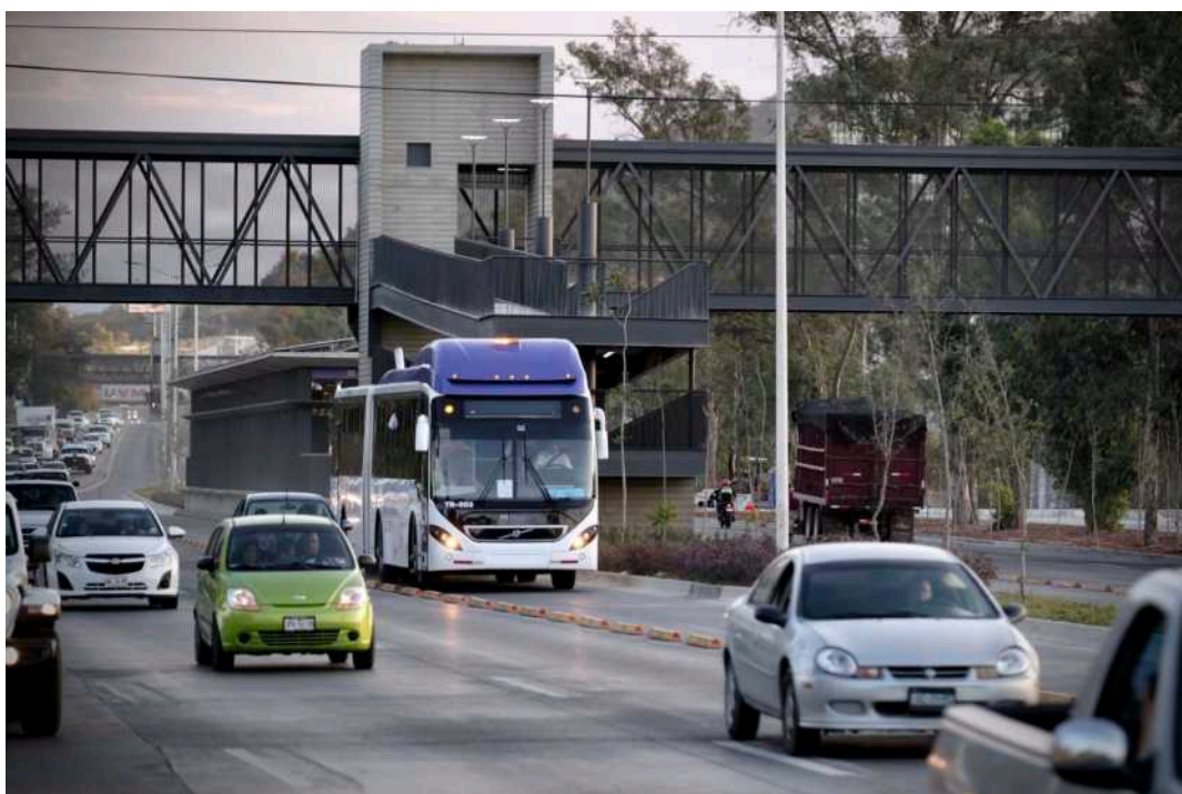
Figura 8. Infraestructura de una estación de Mi Macro Periférico.
